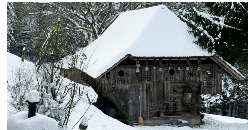
Der älteste Speicher von Wyssachen, gebaut um 1705. The oldest Speicher of Wyssachen, built around 1705.
