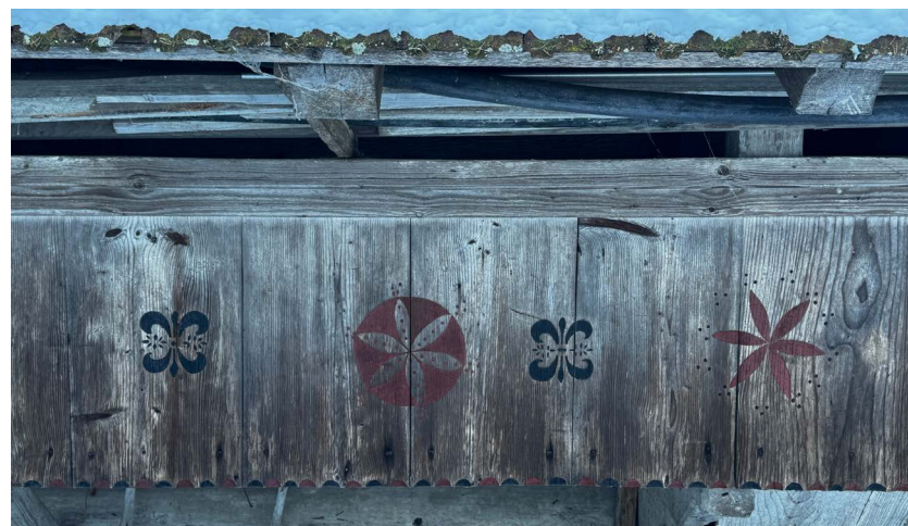
Detail des ältesten Speichers von Wyssachen. Detail of the oldest Speicher of Wyssachen.
